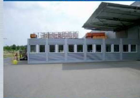
Container mit Außenverkleidung
